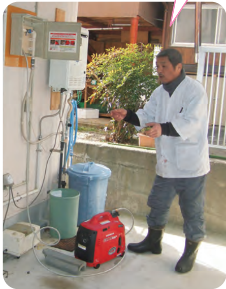
水害で浸水しないよう保管も注意されています
