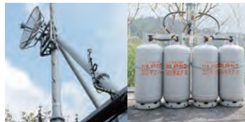
3つの基地局に設置されています
